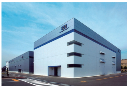
酵素医薬品工場（青森県八戸市）
